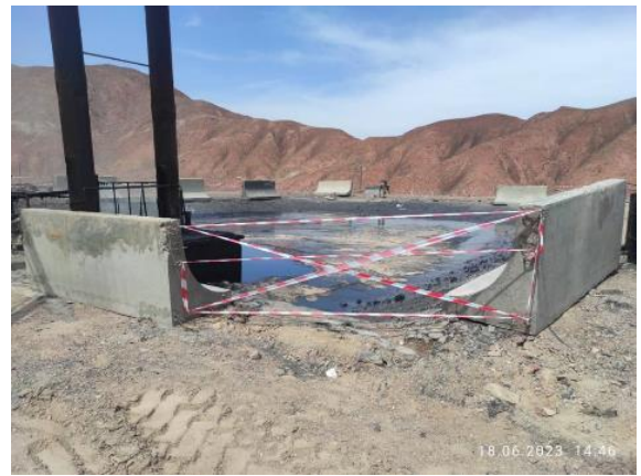
Фото 77. Производственная база АБЗ. Обеспечено завершение полного ограждения места хранения битума.
