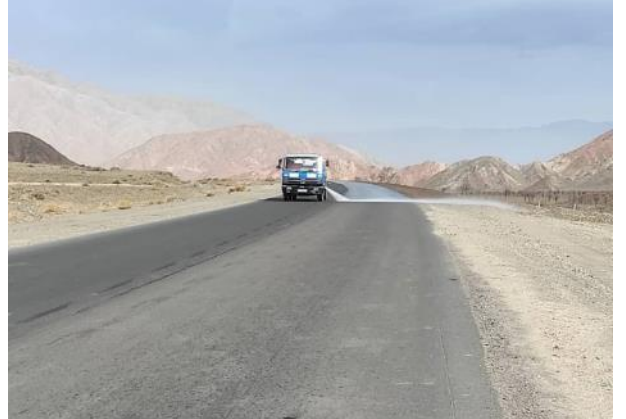
Фото 12. Гидроорошение дорожного полотна км. 19+700. 07.04.2023 г.
