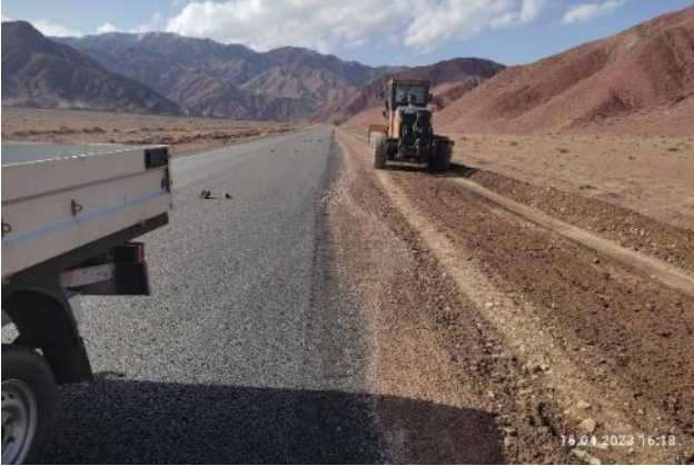
Фото 11. Земляные работы: планировка обочины. Км. 18+500. Апрель
