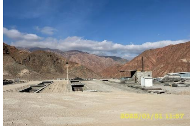
Фото 56. Участок изготовления ЖБИ. Санитарное состояние территории удовлетворительное. Январь.
