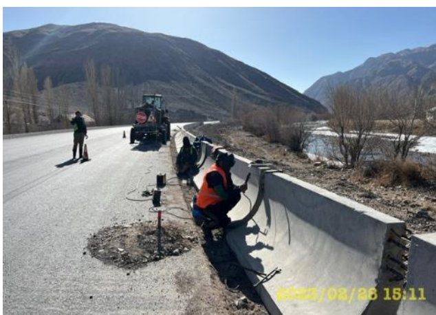
Фото 7. Лот 1. Монтаж установленных парапетов с км 14+000-15+000. Февраль
