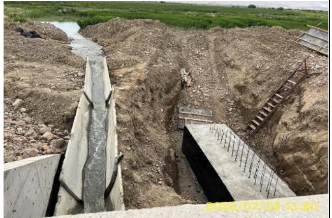
Фото 109. Мост р.Мукандын-Суусу, км. 68+040 Обеспечен отвод воды, предотвращающий попадание грунта в реку, при строительных работах.
