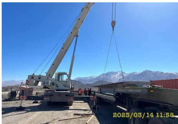
Фото 27. Монтаж мост на км. 65+360. Март
