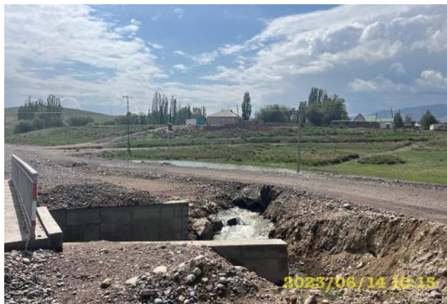
Фото 110. Объездная дорога моста на км 86+261. р. Саздын-Суусу,. Строительство моста завершено, проезд по мосту открыт. Объездная дорога подлежит рекультивации.
