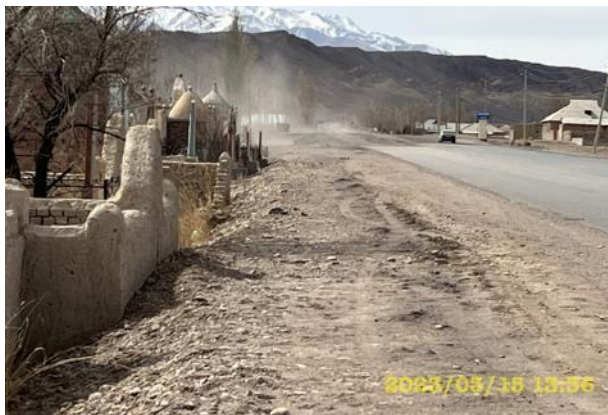
Фото 86. Лот 2. Март Кладбище на км 68 слева от дороги без ограждения и находится в непосредственной близости к дороге: в результате обустройства обочины дороги некоторые участки ограждения могилки были засыпаны грунтом
