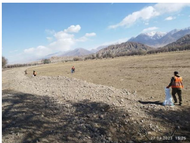
Фото 82. Лот 2. Март. Санитарная очистка территории вдоль проектной дороги ПК 63+480
