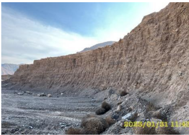
Фото 62 и 63. Лот 1. Карьер км 16+600. Требуется привести устойчивость бортов карьера в безопасное состояние, т.е угол наклона борта карьера д.б. равным 70°(не более).
