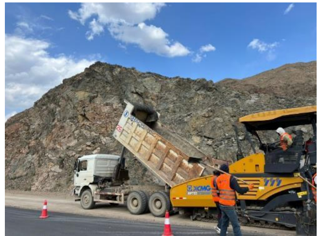
Фото 20. Укладка бейс. 42+000-42+920 LHS. Июнь
