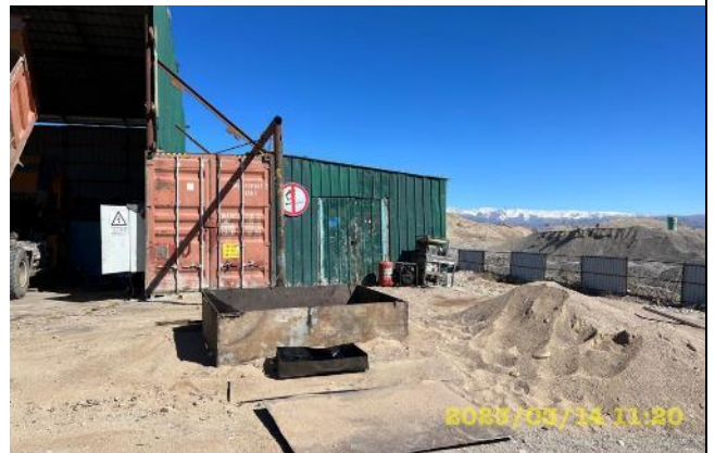
Фото 91. Лот 2. Участок перед складом хранения ГСМ на территории производственной базы после очистки от загрязнений и мусора.
