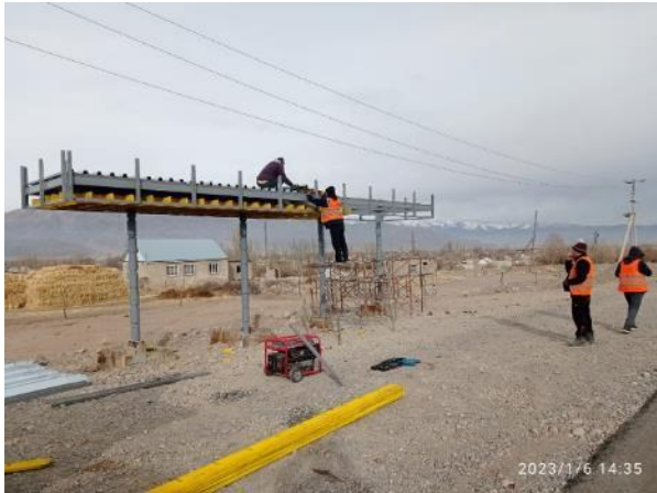
Фото 25. Строительство остановочного навеса км 86+782 RHS. Январь
