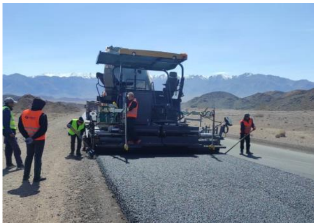
Фото 13. Укладка асфальта. ПК 20+200. Апрель
