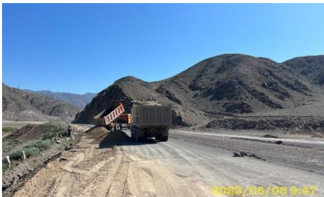
Фото 21. Земляные работы: км.42+000-43+000 Июнь
