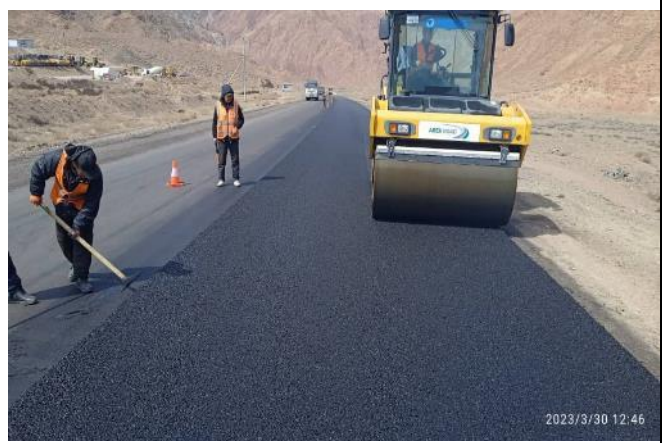
Фото 14. Укладка ЩМА. LHS 15+530--15+870-км. Март
