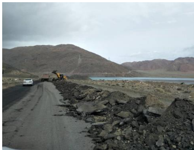
Фото 19. Вскирковка старого асфальта. Км 39. Май
