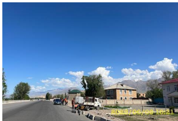
Фото 36. Установка бордюра. С.Кок-Джар. Июнь.
