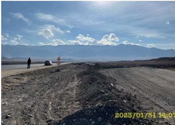
2023/01/31 14:07 Фото 66. Лот 1. Объездная дорога на участке км. 22+000-23+000. Подлежит рекультивации.
