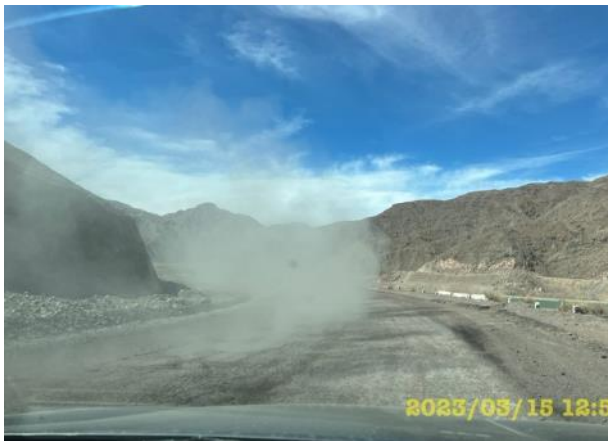
2023/03/15 12:55 Фото 68. Март. Пыль на грунтовом участке дороги км. 37+000-38+000
