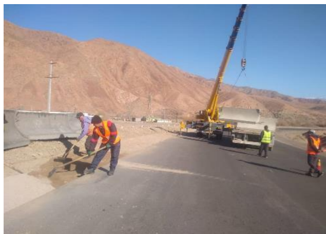
Фото 10. Лот 1. Установка парапетов на км.14+300. Март
