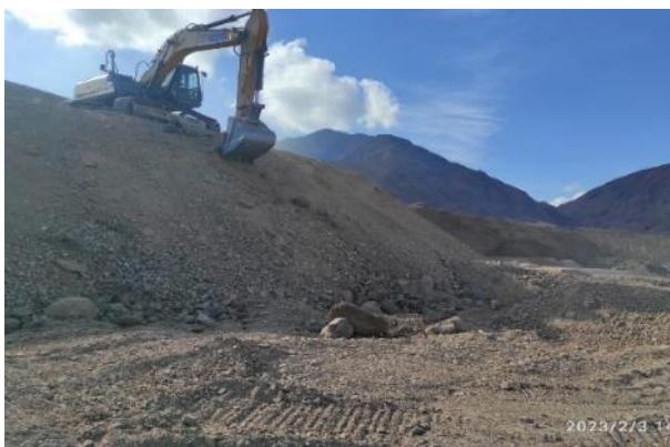
Фото 64. Карьер км 16+600. Ведутся работы по обеспечению устойчивости бортов карьера.
