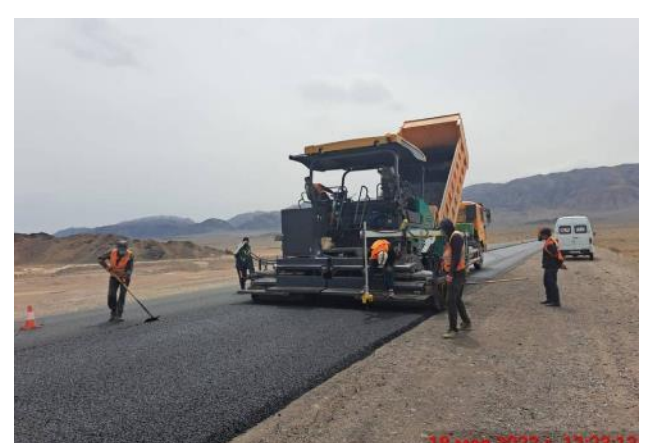
Фото 16. Укладка асфальта. Май
