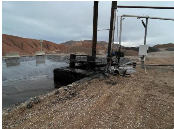
Фото 76. Производственная база АБЗ. Заграждение вокруг места хранения битума подлежит завершению
