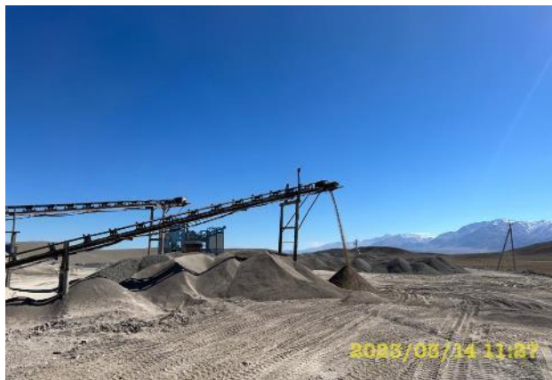
Фото 88. Заготовка строительных материалов на ДСУ. Март
