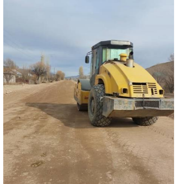
Фото 24. Уплотнение саббейс слоя (2 слой) км 70+340-70+740 RHS. Январь
