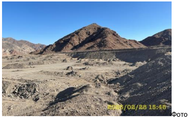
Фото 65. Борта карьера км.16+600 приведены в безопасное состояние
