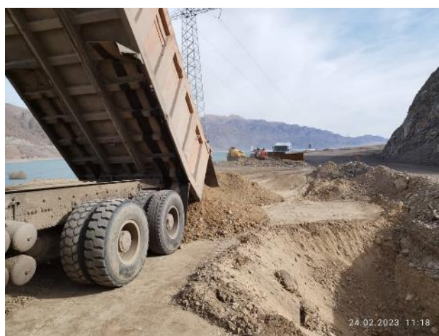
Фото 8. Лот 1. Зем. работы на км. 40+800. Февраль
