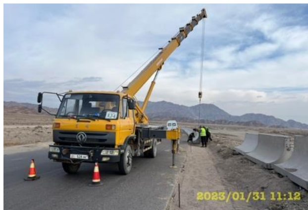
Фото 5. Лот 1. Установка парапетов км.22+850-22+970 LHS. Январь
