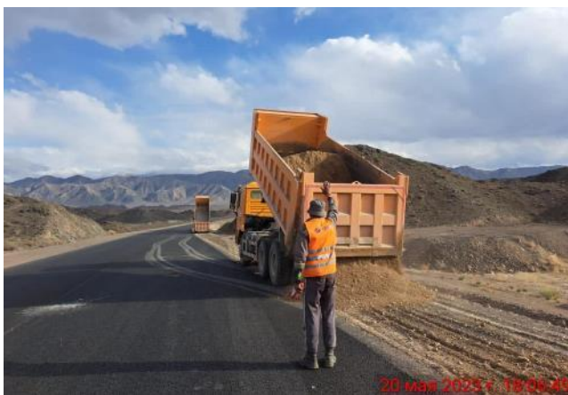
Фото 15. Устройство обочины км. 20+500. Май
