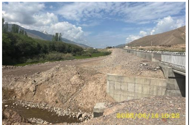
Фото 111. Объездная дорога моста на км 88+795. р. Жар-Корунду. Строительство моста завершено, проезд по мосту открыт. Объездная дорога подлежит рекультивации.
