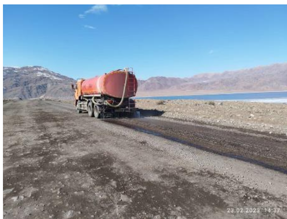
Фото 9. Лот 1. Гидроорошение грунтовых участков дороги км. 41+000-43+000. Февраль
