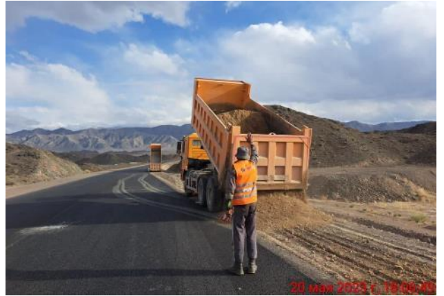
Фото 18. Устройство обочины км. 20+500. Май
