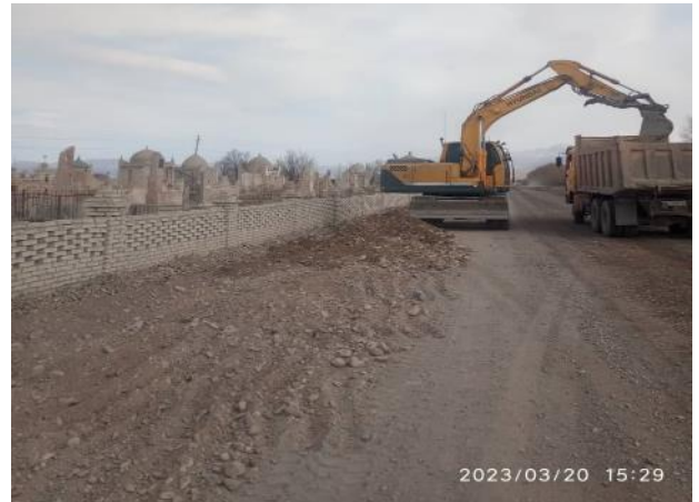
Фото 85. Лот 2. Март. Кладбище на км 68 справа от дороги: произведена очистка территории вдоль забора кладбища от засыпанного грунта
