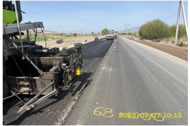
Фото 30. Укладка нижнего слоя асфальтового покрытия на км 68+000. Май
