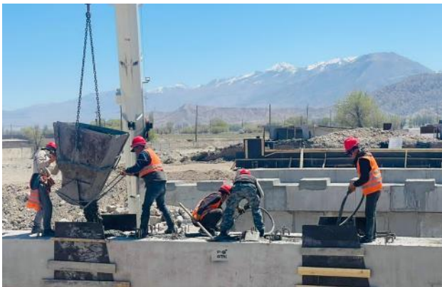
Фото 31. Мост на км. 65+410. Монолитный бетон, соединение ригеля. Май
