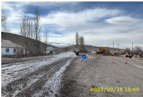
Фото 100. Гидроорошение грунтовых участков дороги км. 69+840-71+000.
