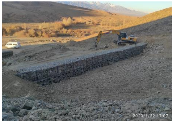
Фото 6. Лот 1. Возведение габиона км.12+795 LHS. Январь
