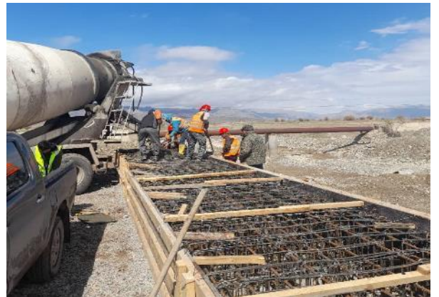
Фото 28. Мост на км. 65+410. Заливка монолитного ригеля 4-ой опоры. Апрель
