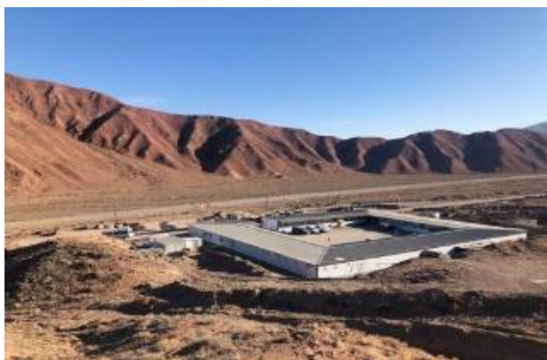
Фото 37. Общий вид лагеря Лот 1 км 16 + 100 (RS).
