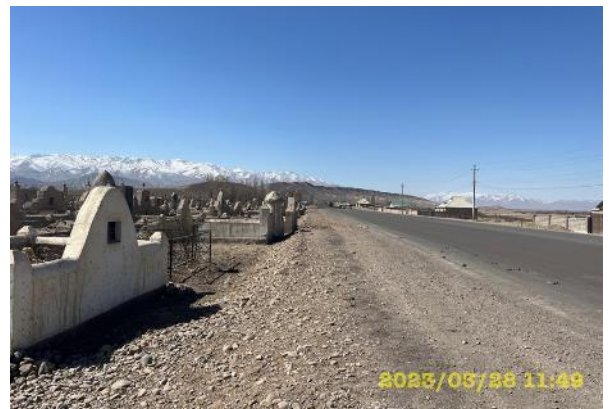
Фото 87. Лот 2. Март Кладбище на км 68 слева от дороги: после очистки участков ограждений могилки от засыпки грунта.
