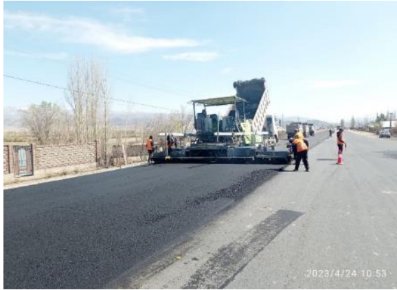
Фото 29. Укладка нижнего слоя асфальтового покрытия на км 69+800-70+370. Апрель
