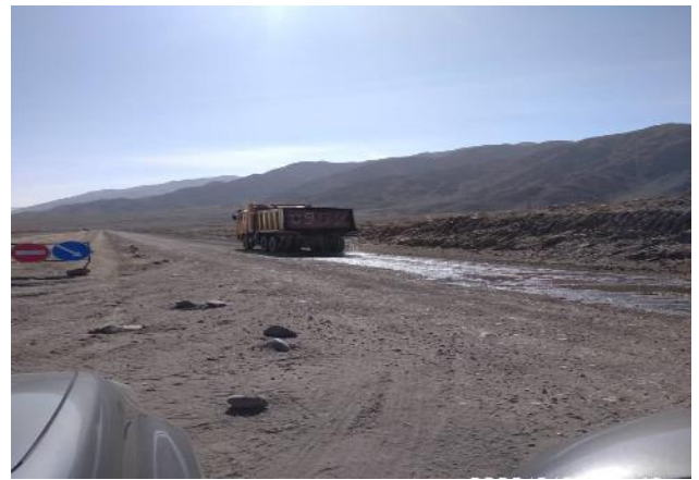
Фото 69. Лот 1. Гидроорошение грунтовых участков дороги на км. 37+000-38+800
