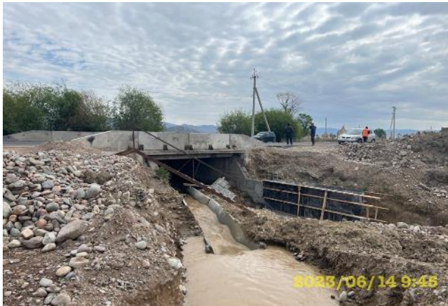
Фото 108. Мост р.Мукандын-Суусу, км. 68+040 Необходимо предусмотреть защитные мероприятия, предотвращающие попадание грунта в реку при производстве строительных работ.
