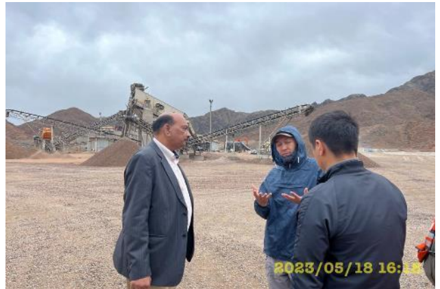
2023/05/18 16:18 Фото 71. Миссия АБР. Лот 1. Производственная база. ДСУ
