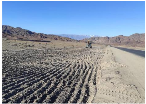
Фото 67. Объездная дорога на участке км. 22+000-23+000. Произведена рекультивация.
