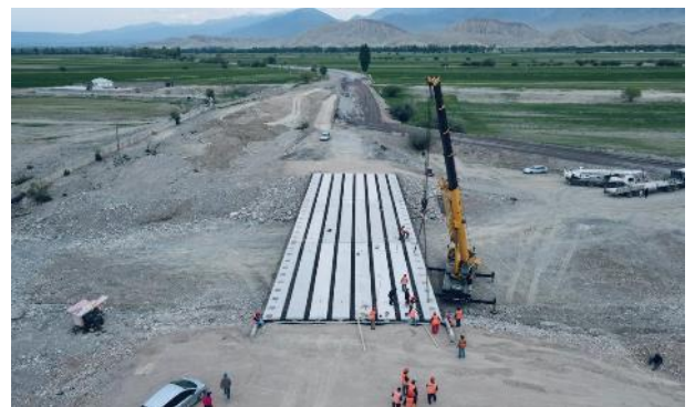
Фото 34. Мост км. 65+410, монтаж плит. Июнь
