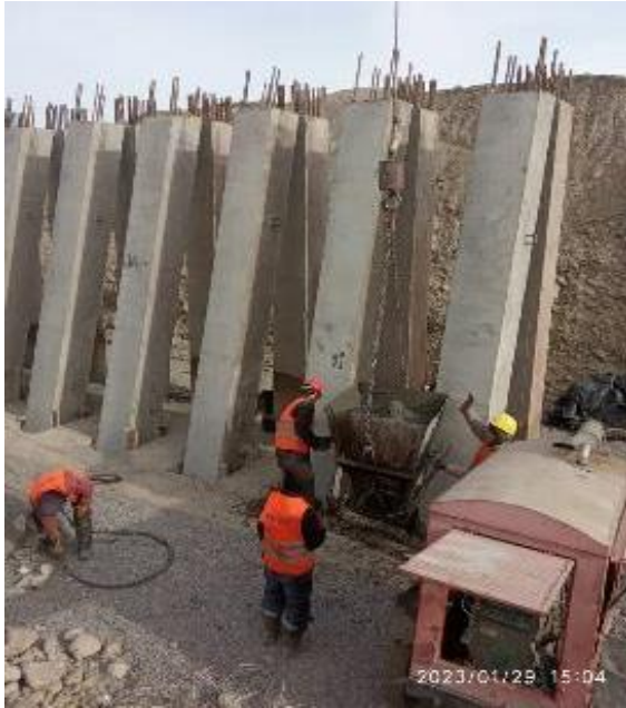
Фото 23. Мост на км 65+410. Омоноличивание стоек с фундаментом. Январь
