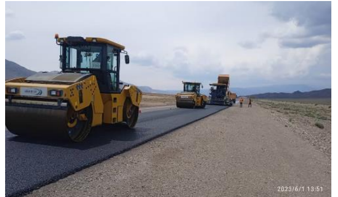
Фото 22. Укладка ЩМА, км.25+935--26+965 RHS. июнь
