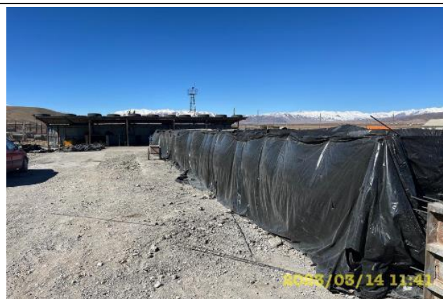
Фото 81. Март. Санитарное состояние территории производственной базы, участок изготовления ЖБИ находится в удовлетворительном состоянии
