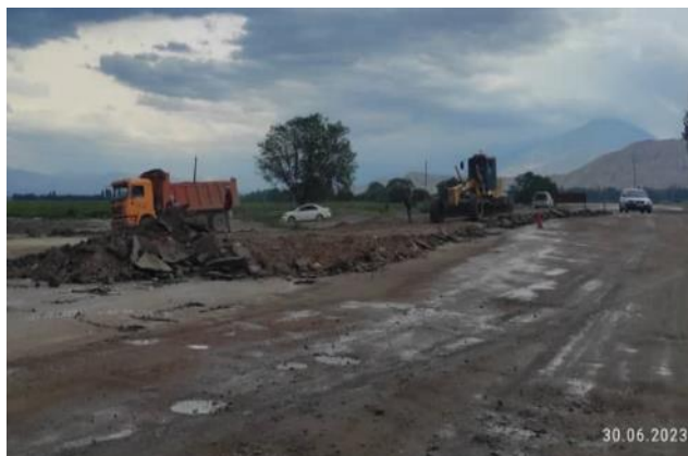
Фото 35. Вскирковка старого а/б км.65+180-65+340. Июнь
