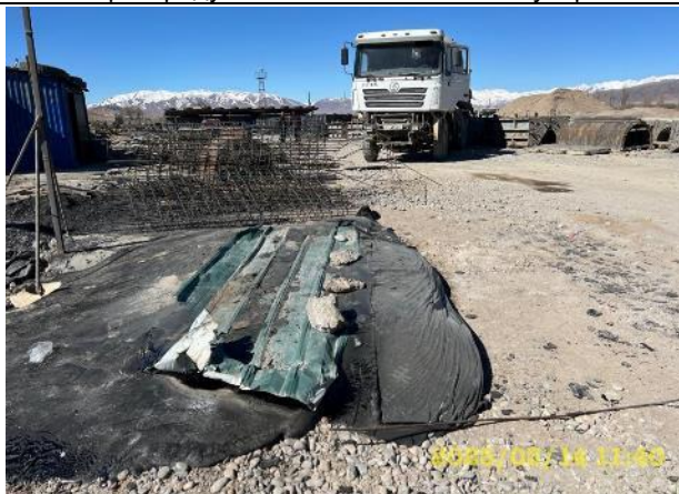
Фото 92. Лот 2. Территория производственной базы, участок изготовления ЖБИ. Роллив битума.
