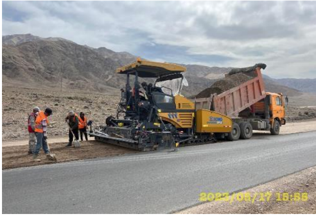
Фото 17. Земляные работы: км.38+000-42+000. Май
