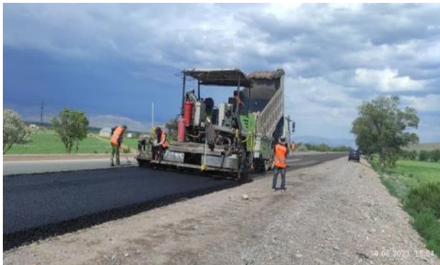
Фото 33. Устройство щебеночного материала на участке км 78+120- км 79+100 LHS. Июнь
